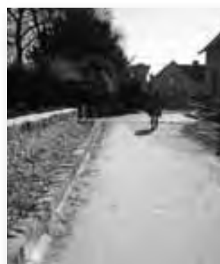
Sur les parties où la nature du sol est ferme, le chemin est en gravas compactés délimité par des bordures en bois.
