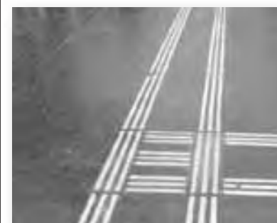
Bande de guidage permettant de se guider tactilement à l'aide d'une canne blanche.
