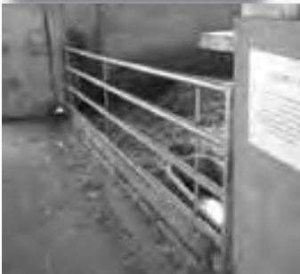
Les barrières sont très peu contrastées et représentent un risque de chute. L'obstacle bas est difficilement détectable visuellement et à la canne.
