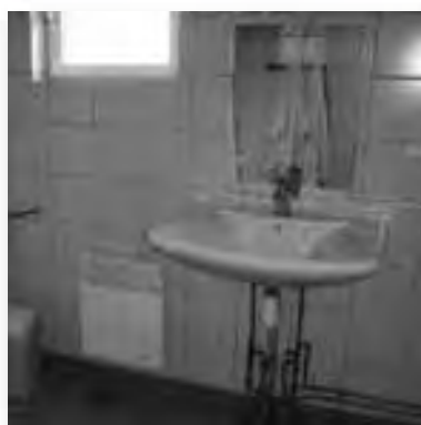
A la ferme de la Boulinière (79), le lavabo de la salle de bain est équipé d'un miroir démarquant juste au dessus et assez haut pour que des personnes assises ou debout puissent s'y voir.
