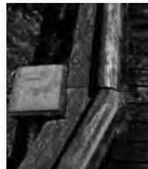
Sur le cheminement de la réserve naturelle de Romelaère (62), des signaux d'éveil au sol (des morceaux de bois taillés en pointe de diamant implantés dans le platelage) indiquent une borne de direction. Celle-ci en relief annonce le changement de direction.
